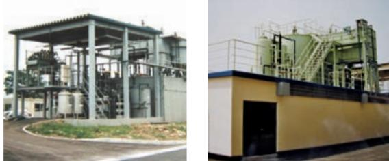
重金属を含む排水は一般に酸性の場合が多いので、水酸化ナトリウム(NaOH)や水酸化カルシウム[Ca(OH)<sub>2</sub>]などを加えてpH値をアルカリに調整すると、金属イオンが水酸化物として析出するので水から分離できます。
